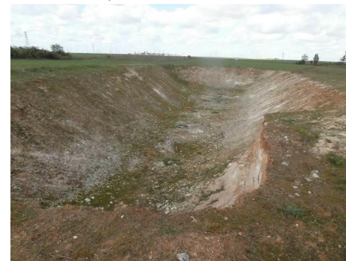
Photo 4 : Bassin de rétention sur l'emprise du projet initial de zone d'activités sur la commune de Boisseaux
